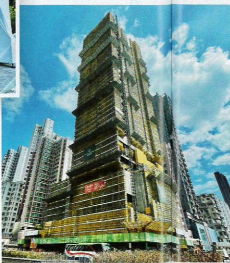
▲組裝合成建築法即是將項目拆成不同組件，並在工廠製造組件，室內裝修及水電在工廠內完成，再直接運送到本港工地裝嵌，有如「砌樂高」(Lego)。
